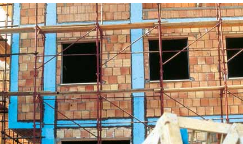
Θερμομόνωση υποστηλωμάτων, δοκαριών
