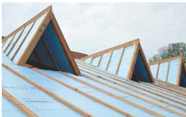
Θερμομόνωση κεκλιμένων στεγών
