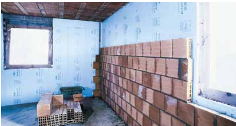
Τοποθέτηση STYROFOAM στην τοιχοποιία
