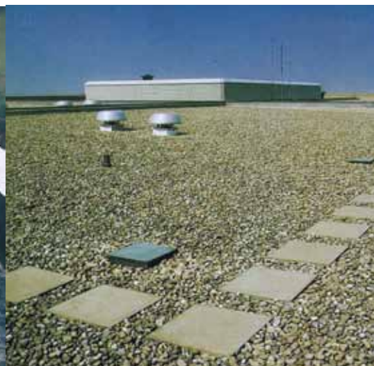
Περίπτωση μη βατού δώματος (έρμα)
