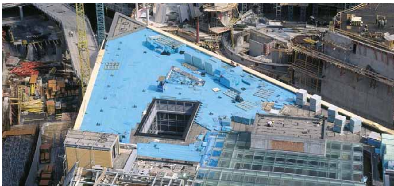
Κατασκευή ανεστραμμένης οροφής
