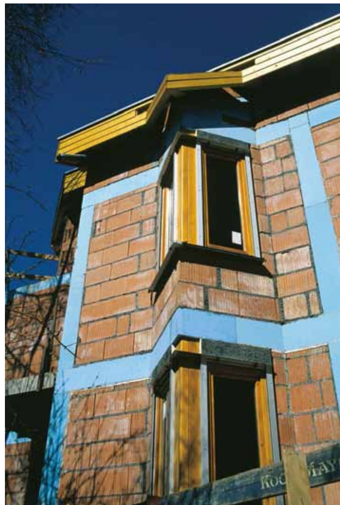
Θερμομόνωση υποστηλωμάτων, δοκαριών
