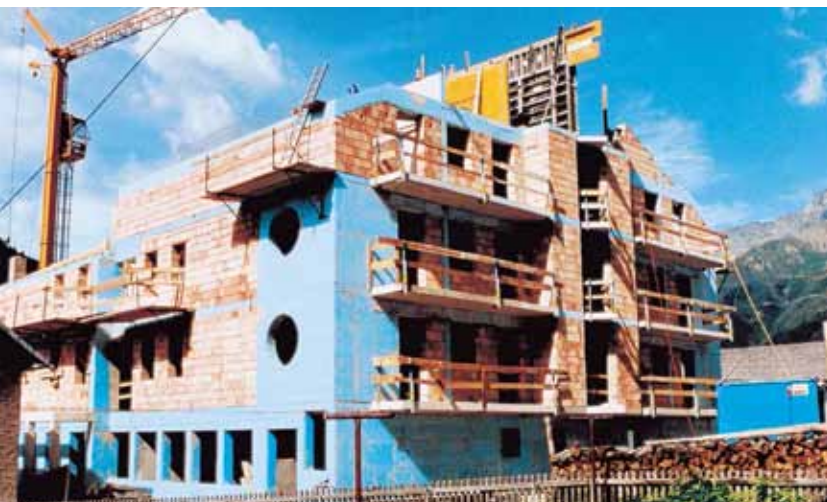
Θερμομόνωση στοιχείων σκυροδέματος
