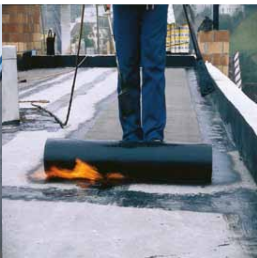
Τοποθέτηση στεγανοποιητικής στρώσης (ασφαλτικές μεμβράνες)
