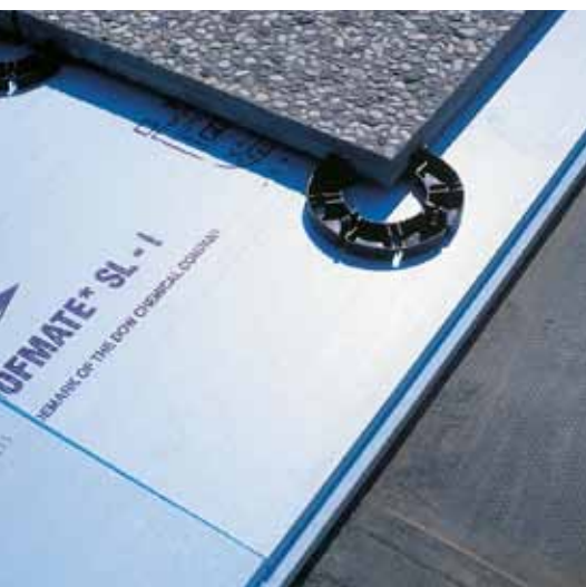
Τοποθέτηση ROOFMATE με τελική επιφάνεια ταρατσόπλακες (βατό δώμα)
