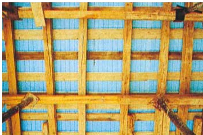
Άποψη ξυλότυπου (άνοψη)
