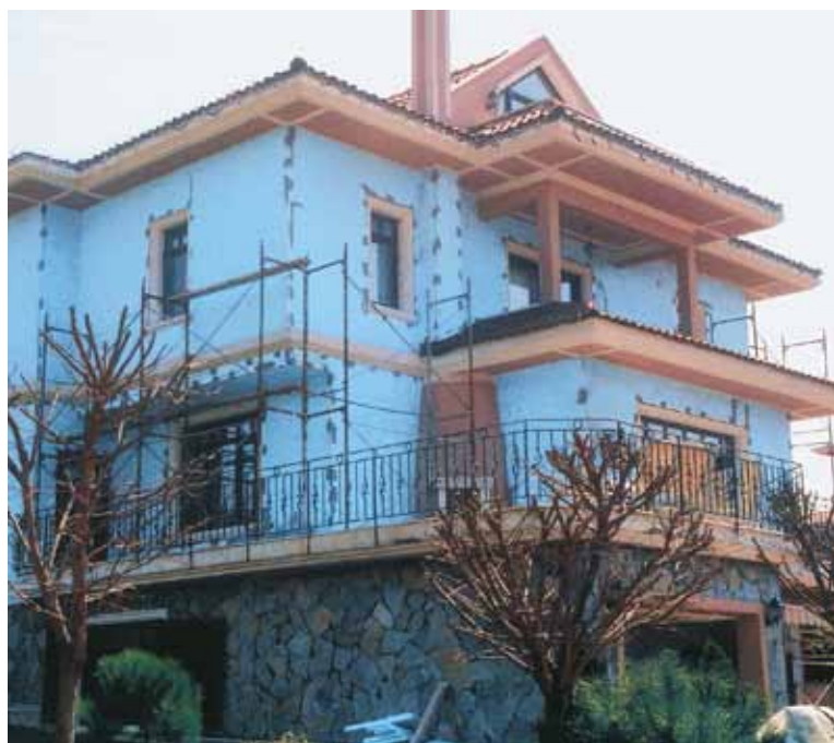
Εφαρμογή εξωτερικής θερμομόνωσης
