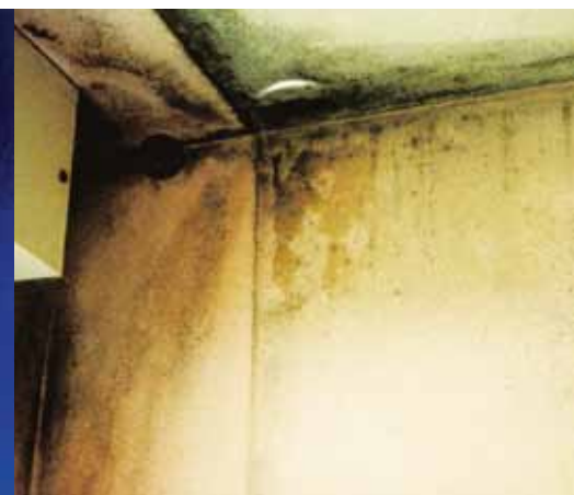
Συμπύκνωση υδρατμών - σχηματισμός μούχλας
